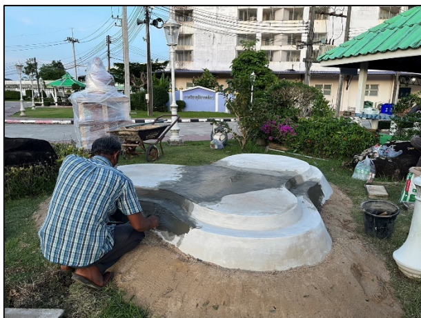
ภาพที่ 51 การติดตั้งฐานของผลงาน ที่มา : ศราวุธ จุลทุม (2565)
