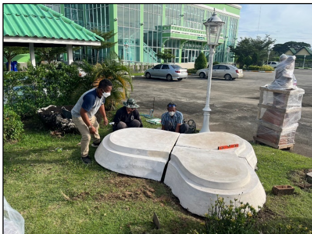
ภาพที่ 50 การติดตั้งฐานของผลงาน ที่มา : ศราวุธ จุลทุม (2565)
