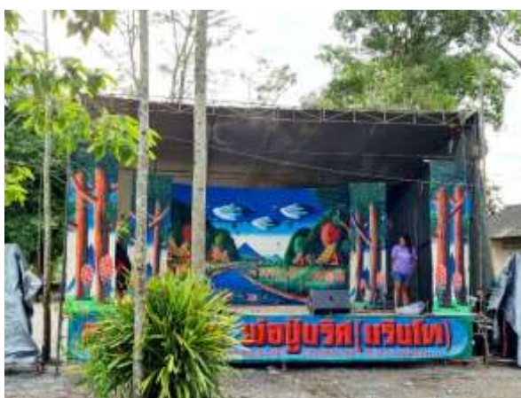
ภาพที่ 18 โรงลิเกที่สร้างจากโครงเหล็ก ปูพื้นเวทีด้วยไม้กระดาน หลังคาเป็นผ้าใบ ที่มา: ผู้วิจัย
