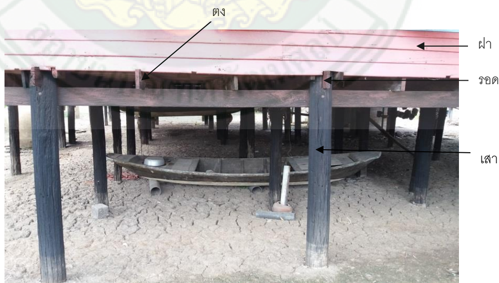
ภาพที่ 112 ตง, ฝา, รอด, เสา
