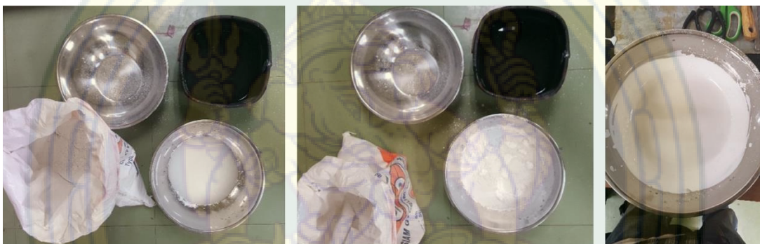
ภาพที่ 171 การผสมปูนปลาสเตอร์โดยใส่น้ำลงไปก่อน แล้วจึงโรยผงปูนปลาสเตอร์ลงไปเบาๆ และผสมปูนปลาสเตอร์ให้เนื้อเข้ากันกับน้ำ
