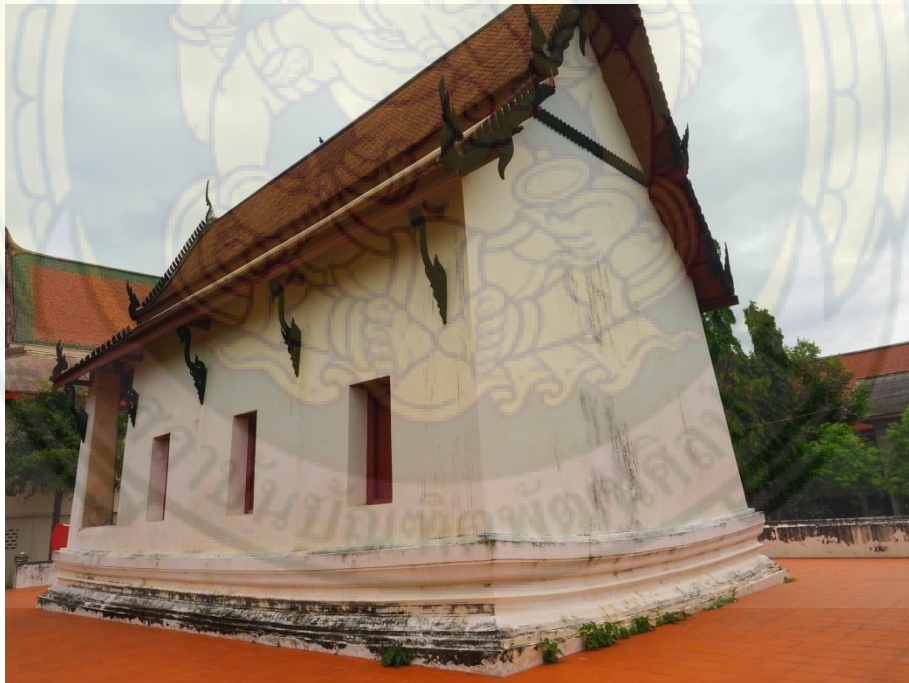
ภาพที่ 4 ฐานปัทม์แอ่นโค้งสำเภาด้านปีกซ้ายของอาคาร
