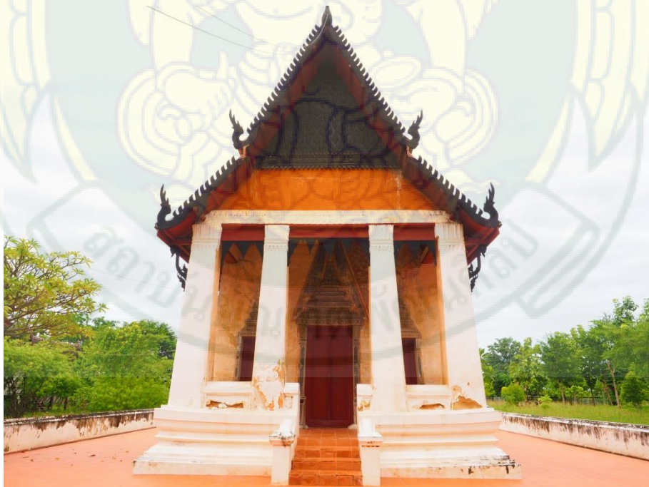
ภาพที่ 2 เสาและตัวอาคารพระอุโบสถมีลักษณะสอบเข้าเล็กน้อย
