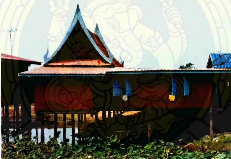
ภาพที่ 78 หน้าจั่วแบบใบปรี๊ด ประกอบด้วยแผ่นไม้ขนาดเล็กเรียงซ้อนกันตามแนวนอน นิยมใช้กับเรือนนอนและเรือนครัว
