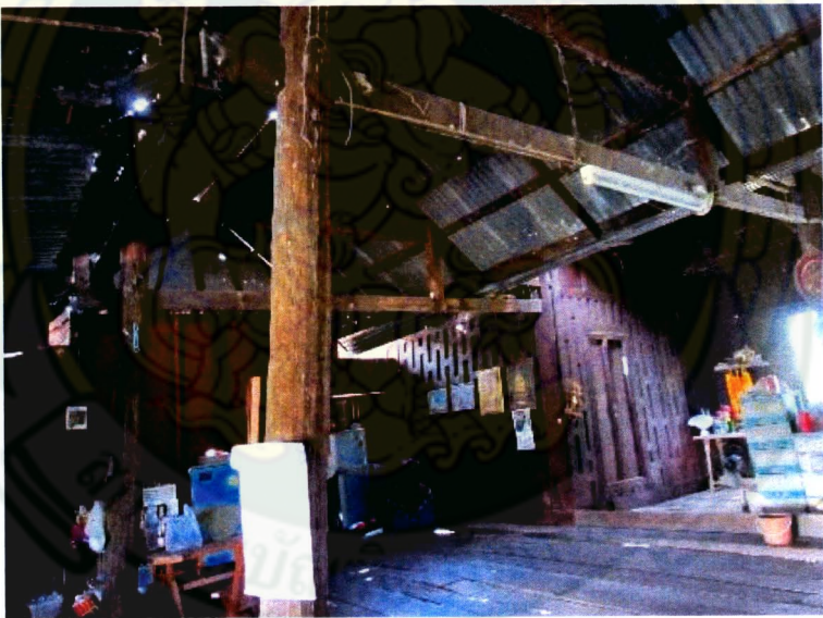
ภาพที่ 56 โครงสร้างเครื่องบน ของระเบียงที่ต่อหลังคาทรงจั่ว
