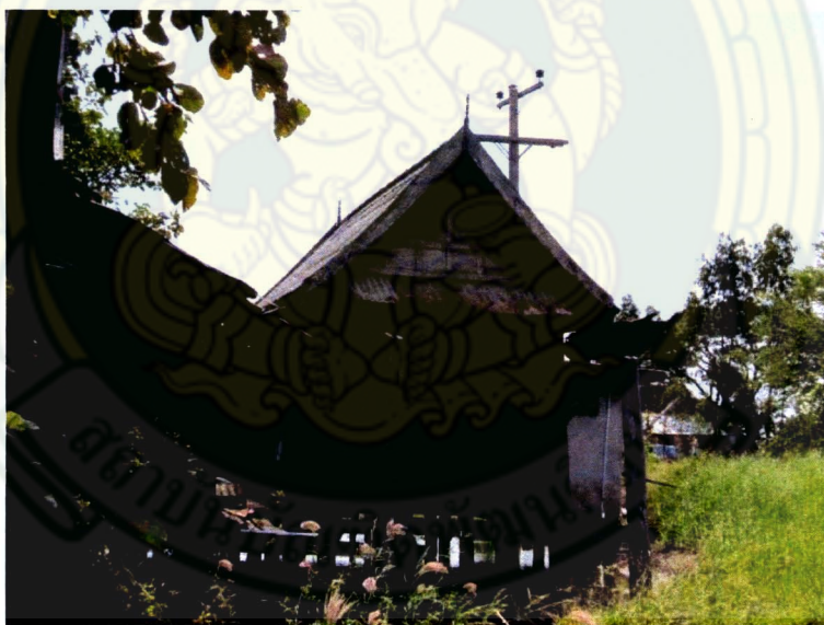
ภาพที่ 86 เรือนครัวด้านหลัง มีหน้าจั่วรูปพระอาทิตย์ คือมีรูปลักษณะคล้ายพระอาทิตย์ครึ่งดวง เส้นรัศมีพระอาทิตย์ทำด้วยไม้แบน และเว้นช่องให้อากาศถ่ายเท นิยมใช้กับจั่วเรือนครัว
