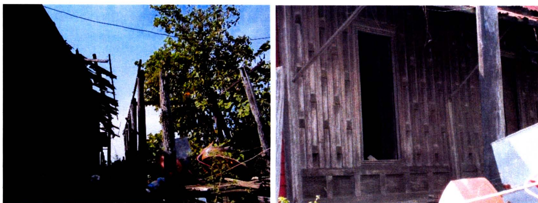
ภาพที่ 85 โครงสร้างยั้งข้าว และฝาปะกน หลังเรือนนอน ที่ยังหลงเหลือ
