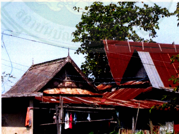
ภาพที่ 84 เรือนใหญ่หลังคาแฝด เชื่อมด้วยเรือนครัว หน้าจั่วพระอาทิตย์ หันหน้าเรือนเข้าหาคลอง
