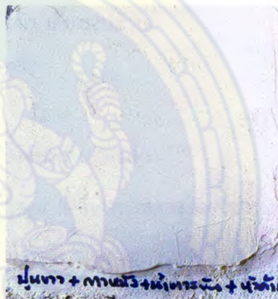
ภาพที่ 87 ภาพการฉาบแบบขัดมันด้วยเกรียงเหล็ก
