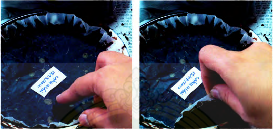
ภาพที่ 37 ภาพการปรากฏชั้นอากาศภายในกระดาะไขกับรัก และการแกะกระดาะไข ไล่อากาศออก แล้วฉนีกใหม่
