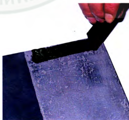
ภาพที่ 98 ภาพการซ่อมกระดานที่สึกดลีงมากเกินไป ด้วยการทาร์กทับจนพื้นเสมอกัน
