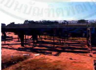
ภาพประกอบ 28 การติดตั้งอุปกรณ์การแสดงหมอลำซิ่ง คณะรัฐจวน ดวงเด่น
