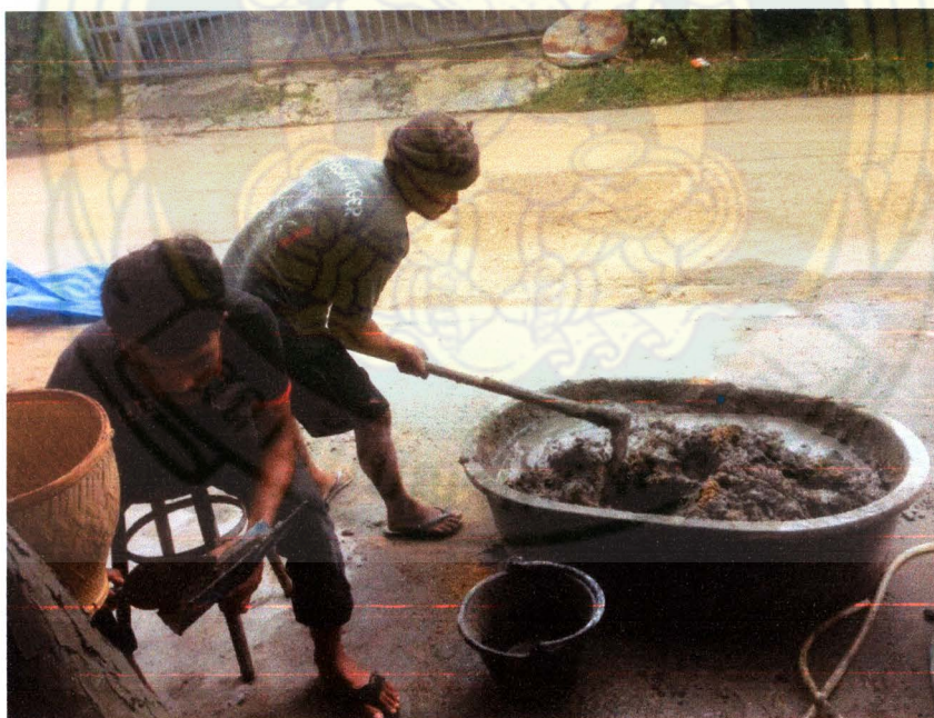
ภาพที่ 34 การผสมปูนผสมเกลบฉาบเคลือบตะแกรงลวดโดยช่างชาวบ้าน
