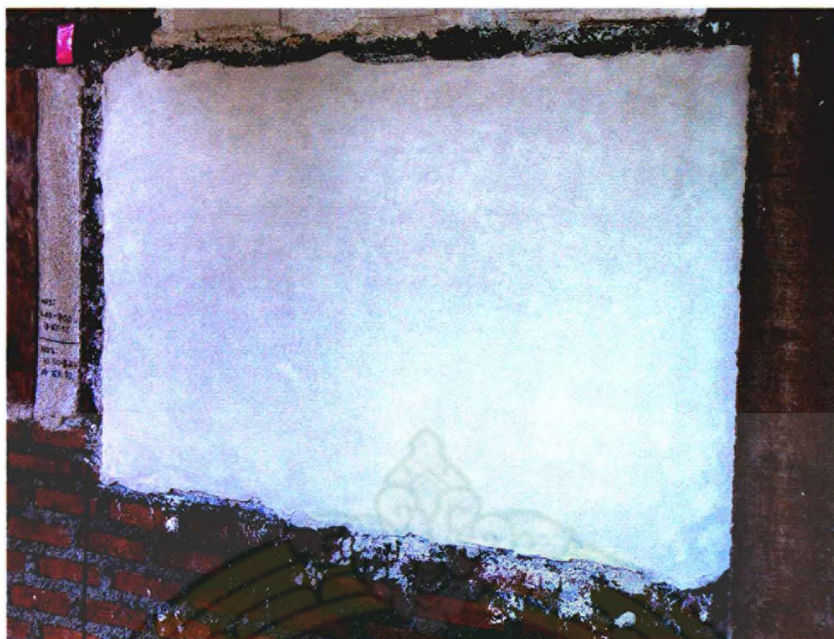
ภาพที่ 87 ภาพแสดงผนังขณะฉาบครั้งที่ 2 แล้ว
