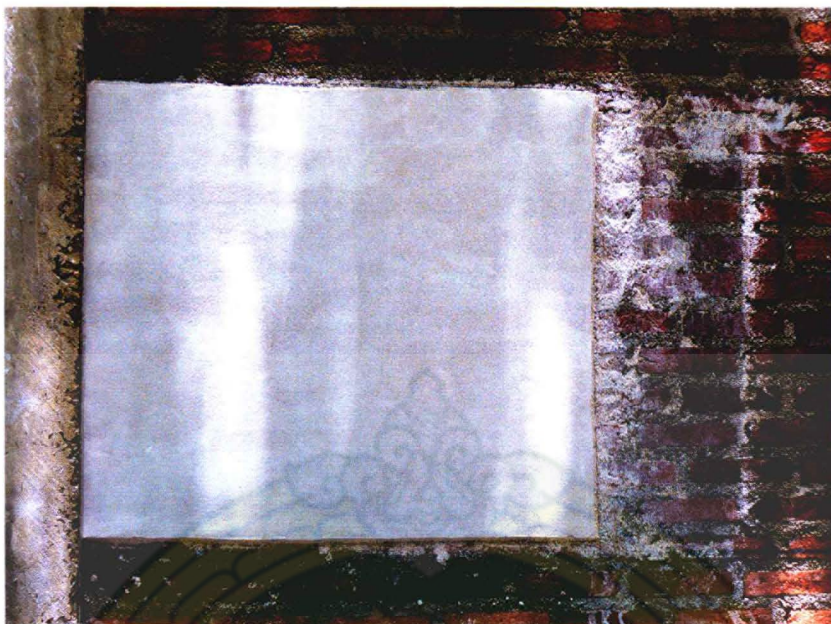
ภาพที่ 45 ภาพการฉาบชั้นสุดท้ายเมื่อแล้วเสร็จ
