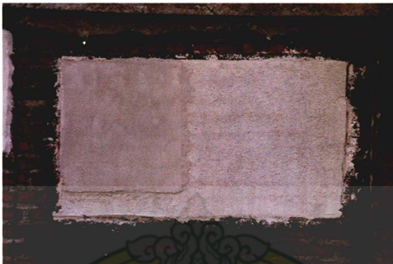
ภาพที่ 71 ภาพแสดงผนังฉาบครั้งที่ 2 แล้ว
