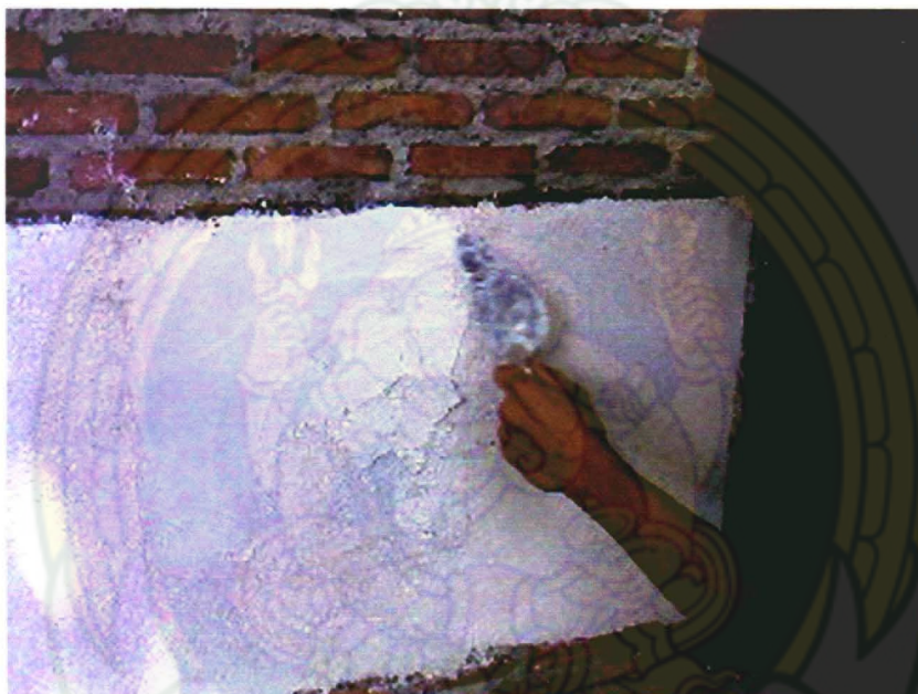
ภาพที่ 81 ภาพการฉาบปูนทำพื้นชั้นที่ 2
