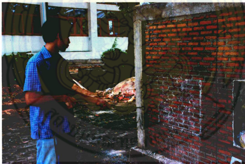
ภาพที่ 42 ภาพการฉีบน้ำเพื่อให้ผนังมีความชื้น
