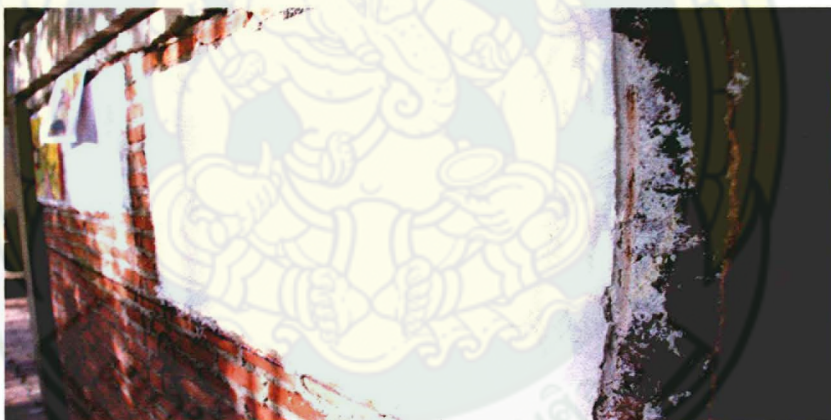
ภาพที่ 70 ภาพแสดงผนังฉาบครั้งที่ 1 แล้ว
