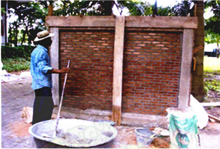
ภาพที่ 7 การสร้างโครงสร้างผนังจำลองในการปฏิบัติงานวิจัย
