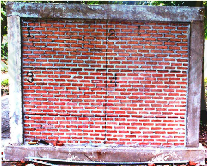
ภาพที่ 8 ภาพผนังที่ก่ออิฐเสร็จแล้ว
