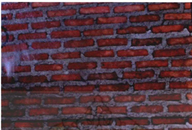
ภาพที่ 32 ผนังควรมีความชื้นก่อนฉาบปูน
