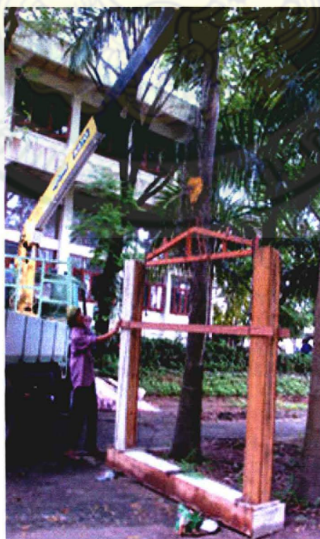
ภาพที่ 6 การสร้างโครงสร้างผนังจำลองในการปฏิบัติงานวิจัย
