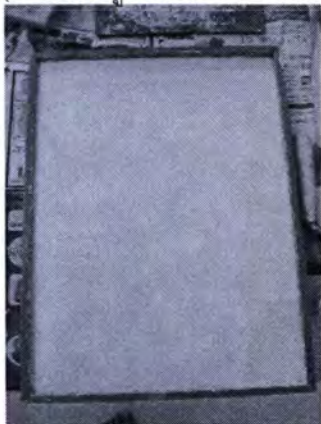
ภาพ 5 (การฉาบปูนครั้งที่ 1 ความหนา 0.3 ซม.) ภาพ 6 (ทิ้งไว้ 1 ซม.)
